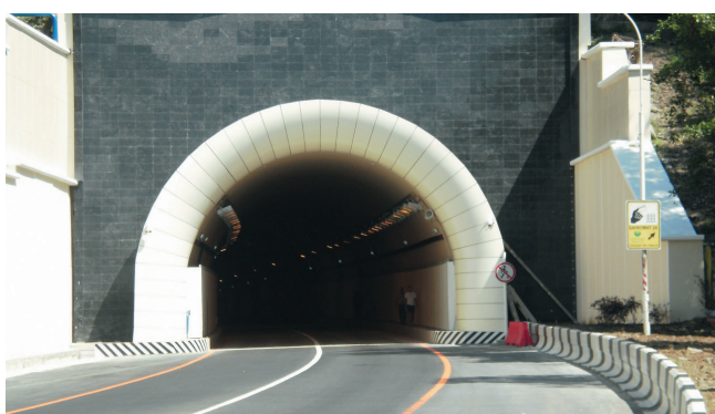
Tunel na federální dálnici M27 z Džugby do Soči, Ruská federace Hydroizolace tunelu | 8 500 m 2 LOGICBASE V-SL 2,0 mm
