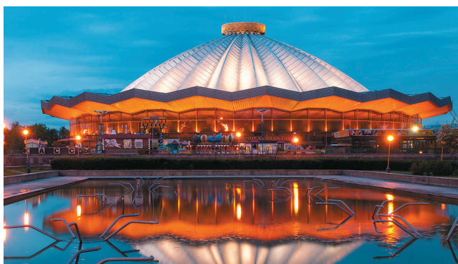
Cirkus na ulici Vernadskogo, Moskva, Ruská federace Hydroizolace stylobatu | 20 000 m 2 LOGICBASE V-SL 2,0 mm LOGICBASE V-ST 1,6 mm
